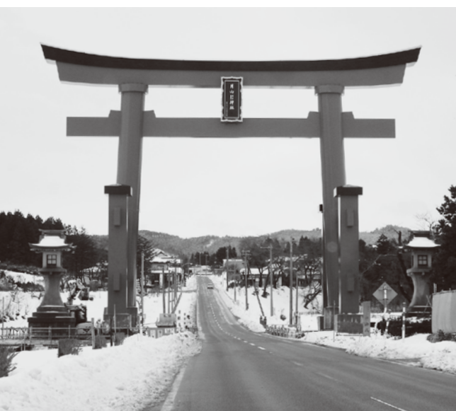
羽黒山 大鳥居 平成30年11月に26年ぶりに老朽化の為建て替え。 高さ 23.8m 笠木の幅 31.6m 従来よりひとまわり大きい。
